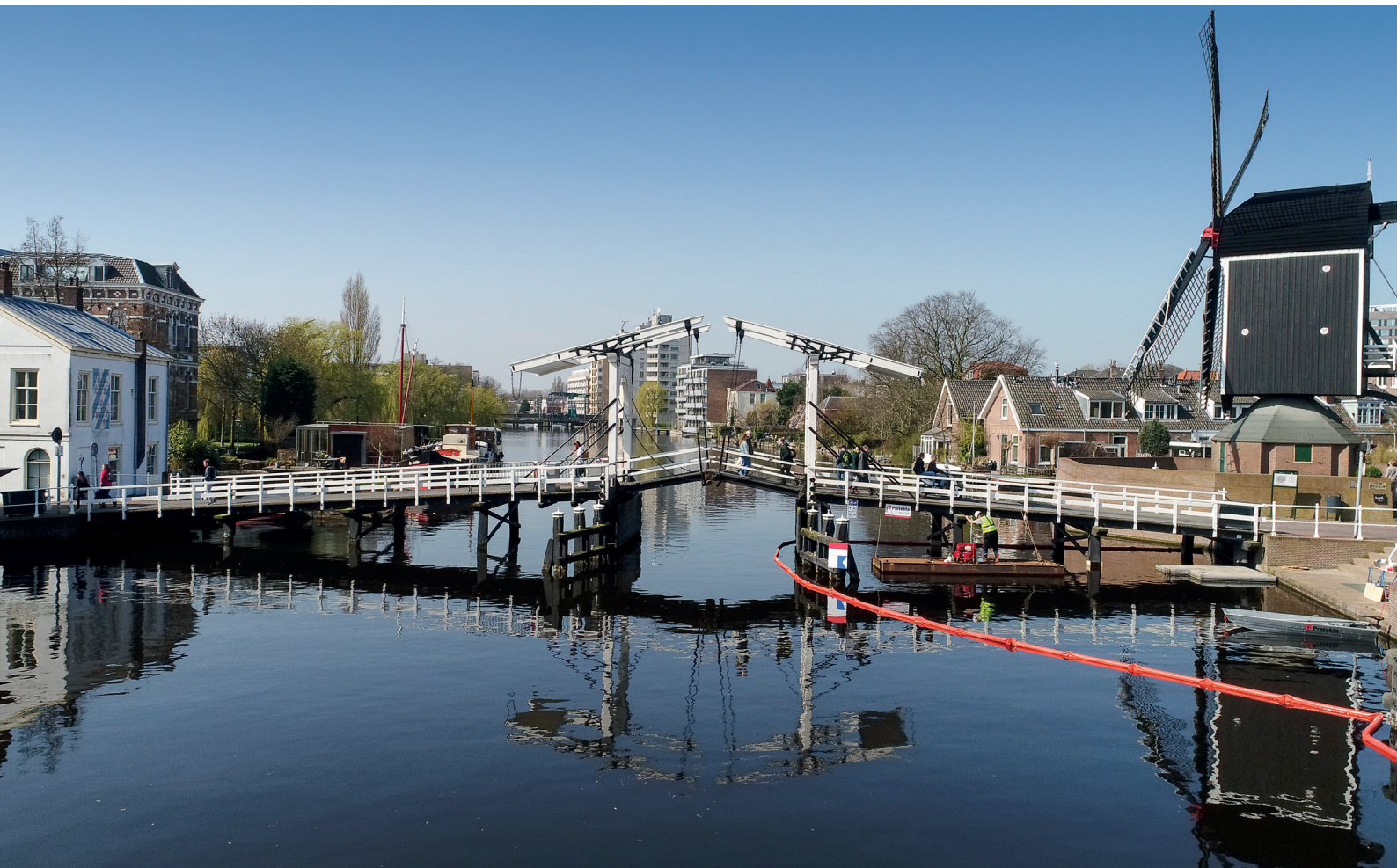
Restauratie Rembrandtbrug Leiden
