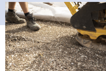
Verdichten van Granova Drainmix.
