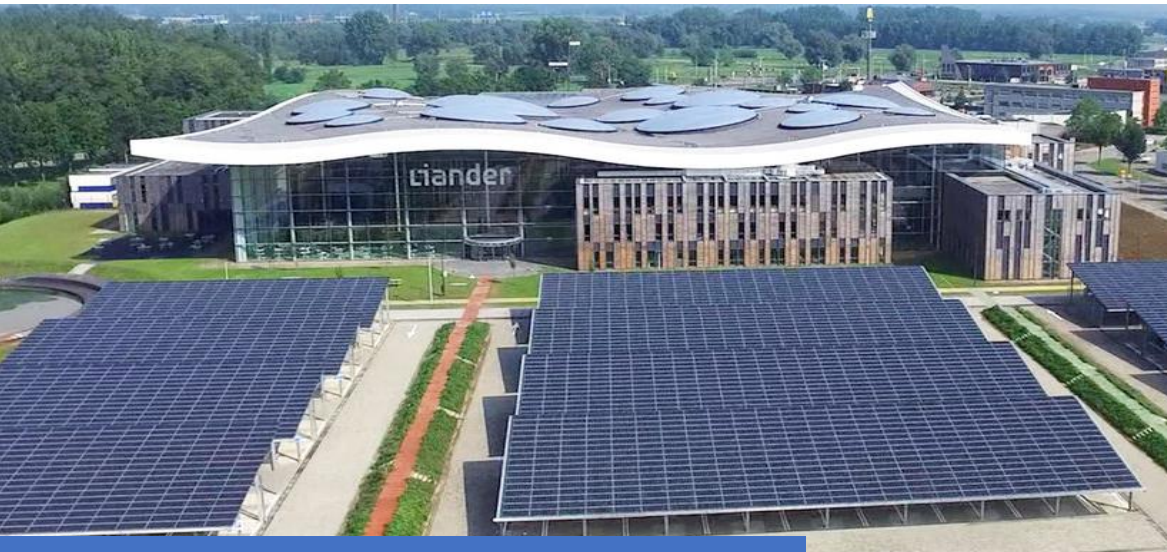
Zonnepanelen boven parkeerplaats kantoor Liander (Duiven)
