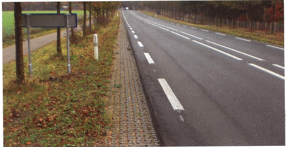
Praktijktoepassing zelfreinigende berm op proeflocatie langs de N310 bij Schaarsbergen.
