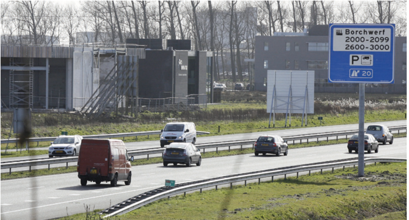
Bedrijventerrein Borchwerf II: nieuwbouw kantoren en kantoren in aanbouw
