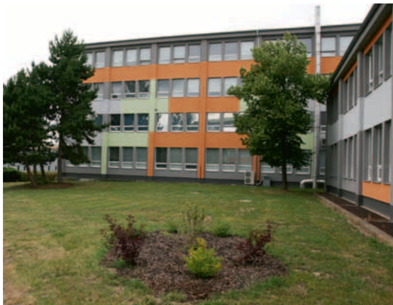
De Mercachem pilot plant in Praag
